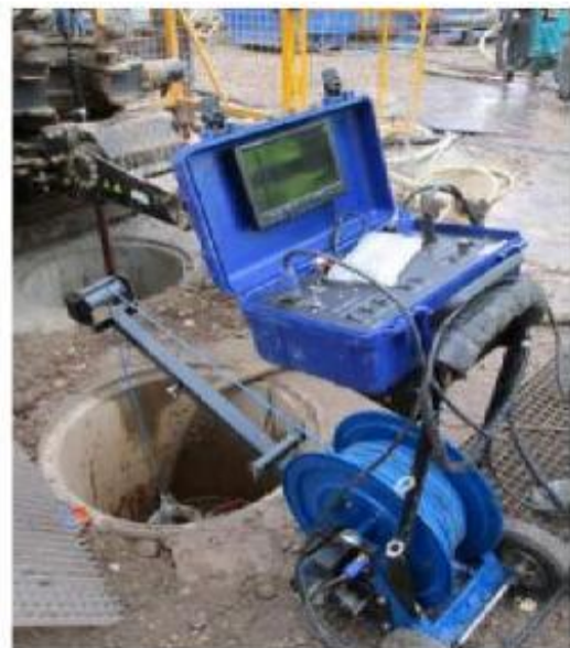
Photo n°2 : Réalisation d'essais dans l'ouvrage PMS
