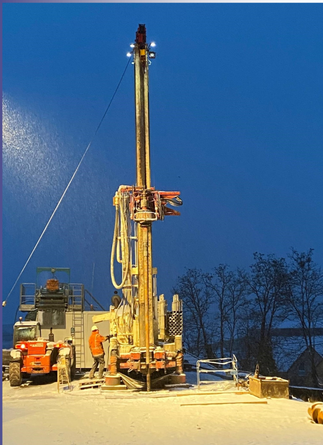
Photo n°2 : Machine de forage en exécution
