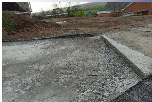
Photo n°1 : Exemple d'aménagement réalisé par la SADE
