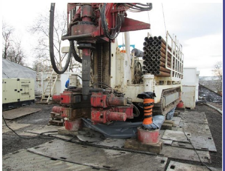
Photo n°1 : Machine de forage en cours d'installation
