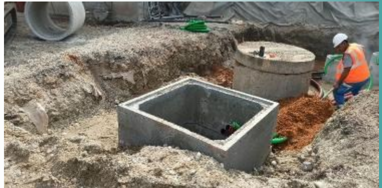
Photo n°1 : Avancement de l'installation des têtes de forage.
