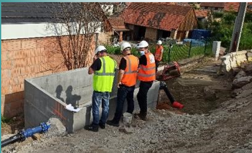
Photo n°2 : Construction du local technique.
