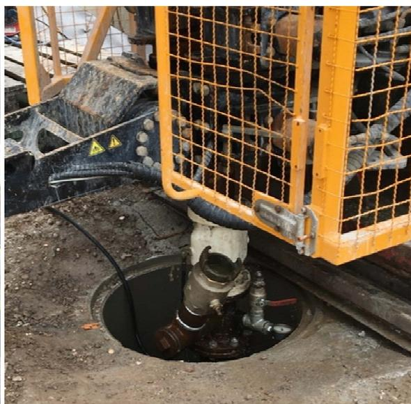
Photo n°2 « Equipement de la tête d'ouvrage en carottage »
