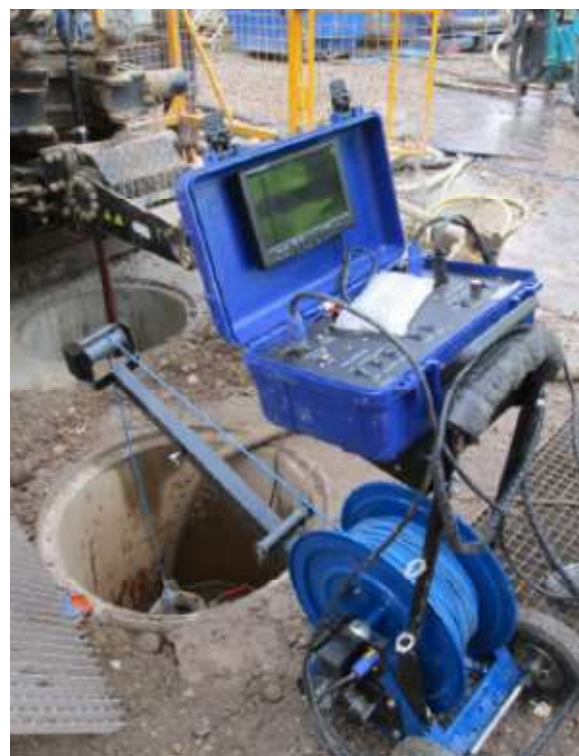
Photo n°2 : Réalisation d'essais dans l'ouvrage PMS
