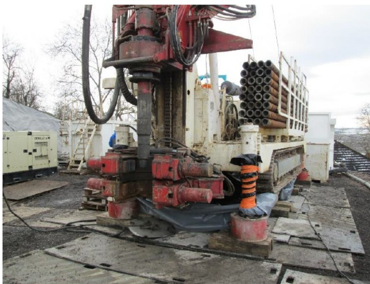
Photo n°1 : Machine de forage en cours d'installation
