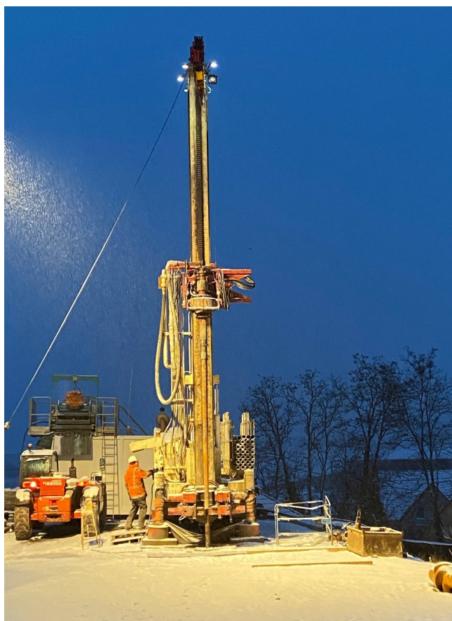
Photo n°2 : Machine de forage en exécution
