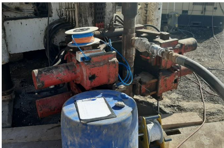
Photo n°1 : Réalisation d'un essai de pompage
