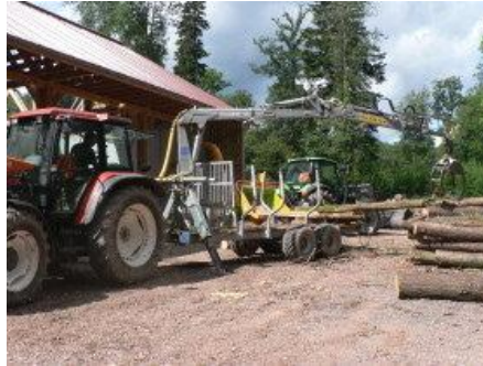
Vue d'ensemble du chantier de fabrication de plaquettes.
