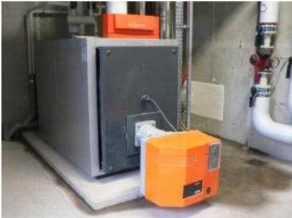
La chaudière fioul sert de chaudière de secours. Elle se met en route automatiquement en cas de défaillance de la chaudière bois.
