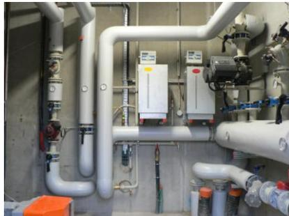
A droite, le collecteur et les pompes de circulation. Au centre, le dégazeur (étiquette jaune) et le contrôleur de pression (étiquette rouge).
