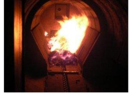
Dans le foyer, la combustion est gérée par un automate. Le déchargement est réalisé grâce à un système de racleurs.
