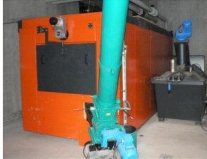
La chaudière bois d'une puissance de 500 kW est alimentée automatiquement en paquettes.
