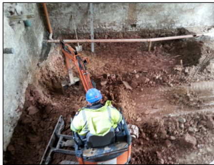
Renforcement des fondations
