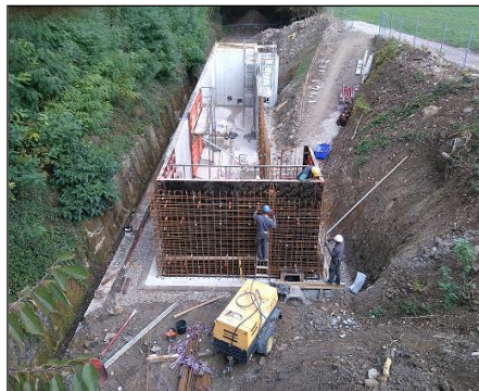
Ferrailage et coffrage du voile phase 7
