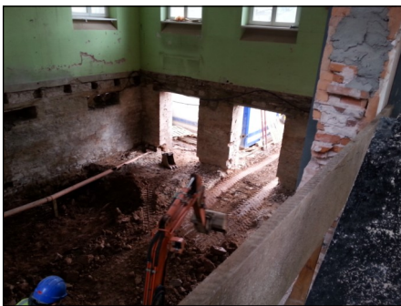
Démolition de la dalle
