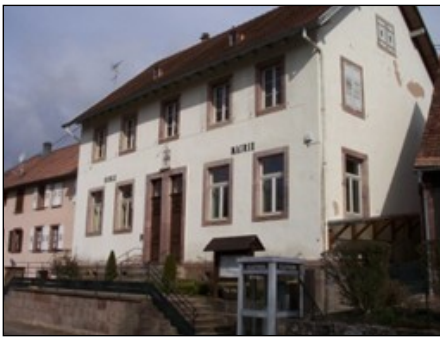
Le bâtiment avant les travaux
