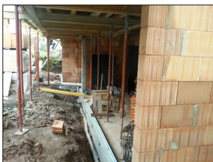
Les murs de l'extension
