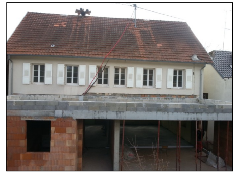
Le bâtiment Vue arrière
