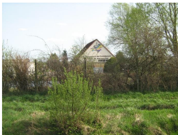
Station d'épuration de Marmoutier
