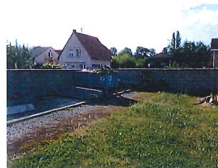
Point collecte des déchets au niveau de l'extension
