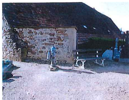
Point d'eau au niveau de l'extension
