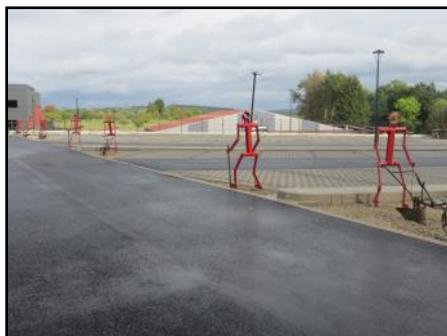
Après la pose de pavés filtrants sur les emplacements de parkings, les voies de circulation quant à eux ont été traitées en enrobés.
