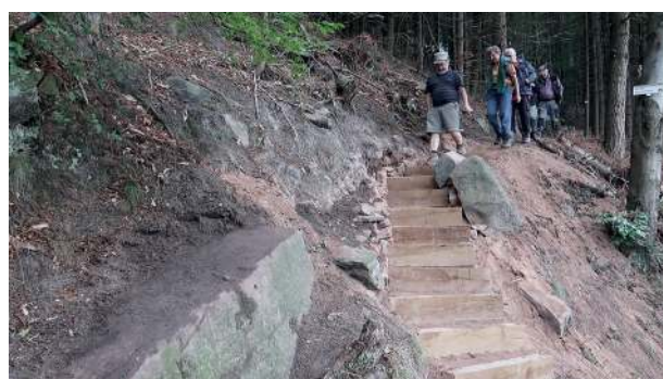
Sentier Obersteigen-Sattelsfels après travaux
