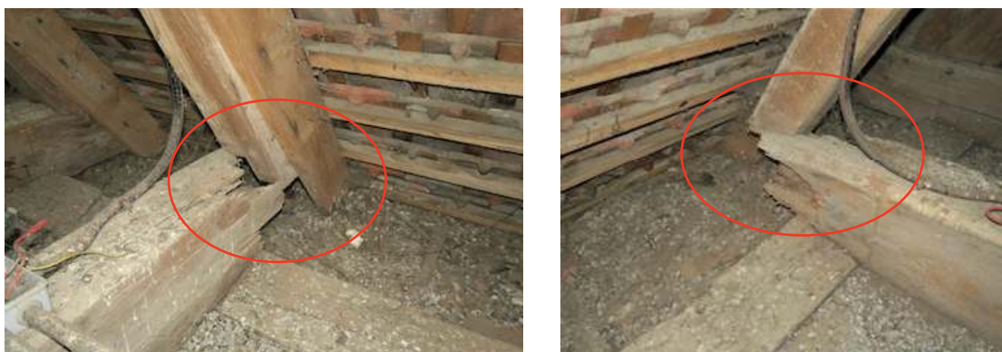
Pieds de ferme pourris : disparition totale de l'about et de la liaison chevron-entrait
