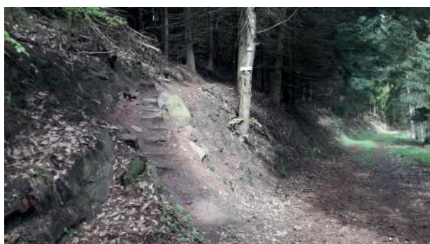
Sentier Obersteigen-Sattelsfels rouge avant travaux
