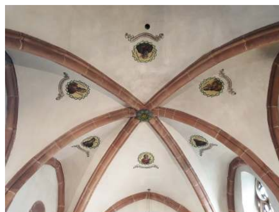
Voûte sexpartite du chœur
