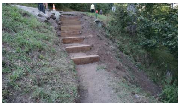
Entrée du sentier Relais Hertzien-Obersteigen après travaux
